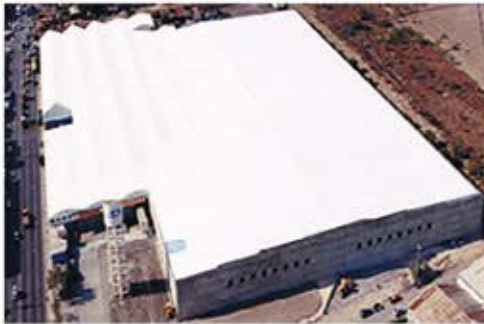
ACS Internacional S. de R.L. de C.V. Guadalupe, Mexico Plant # 2
